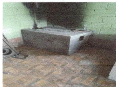
Foto 4: Trabajando en la construcción de la estufa rural completa
