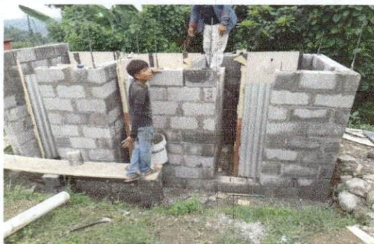
Foto 1: Trabajando en la construcción de las paredes de los baños
